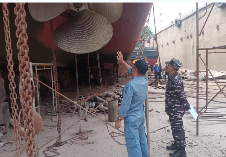
Verifikasi pemasangan propeller shaft dan daun propeller KRI
